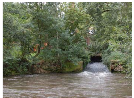
Überlauf des Mühlkanals in die Lauter
